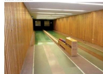
Kegelbahn im Kellergeschoss
